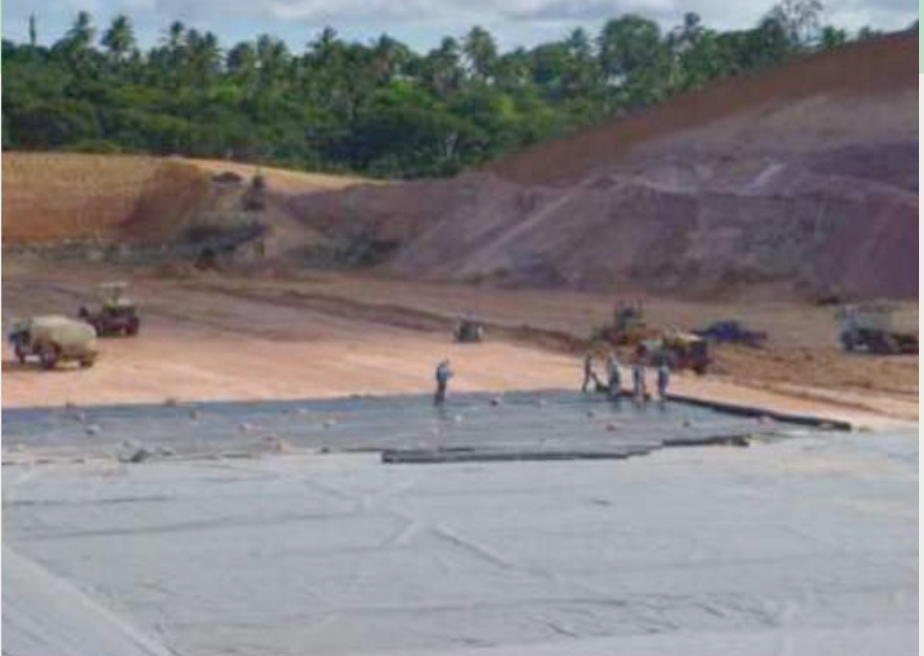
Figura 14 – Aterro impermeabilizado com argila e mantas de polietileno de alta densidade (PEAD)
