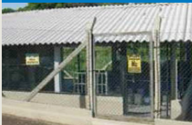
FIGURA 4 – EXEMPLO DE LOCAL ADEQUADO PARA ARMAZENAMENTO DE RESÍDUOS SÓLIDOS
